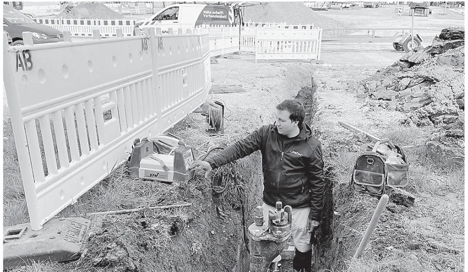
**Das Wasserversorgungsteam der Stadtwerke, wie hier Michael Eckstein, führte wichtige Umverlegungen von Wasserleitungen und Hydranten auf dem Volksfestplatz im Zuge der Sanierungsarbeiten durch. Foto: Stadtwerke**
