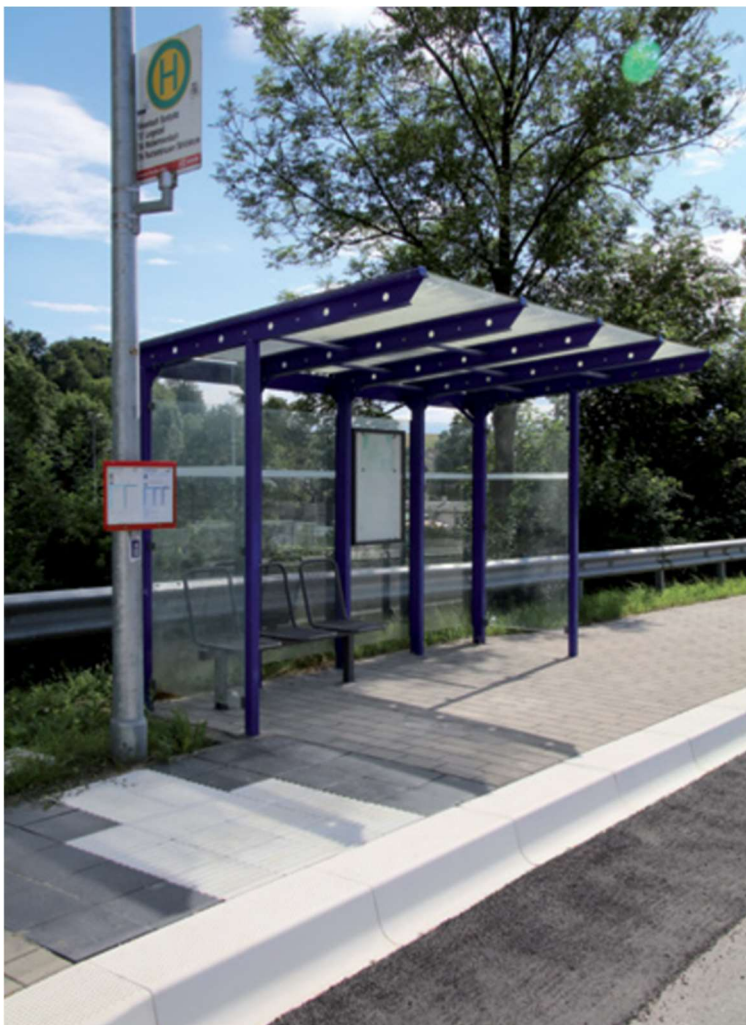
Abbildung 2: Beispiel einer barrierefreien Haltestelle (Quelle: Verkehrsverbund Rhein-Neckar - VRN)
