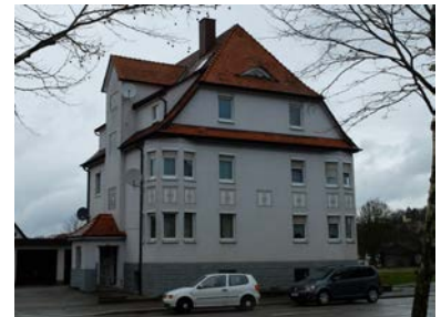
Schönebürgstraße 15: Wohnhaus, 1921 als Haus eines Gipsermeisters neu erbaut; Beispiel für das anspruchsvolle Bauen im späten Heimat- bzw. Jugendstil am Stadtrand.
