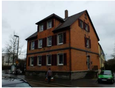
Schillerstraße 18: Wohnhaus eines Handwerkes (Wagenbaumeister), 1895 erbaut, 1897 und 1903 erweitert, baulicher Hinweis auf die vorstädtische, handwerklich geprägte Bebauung in Crailsheim.
