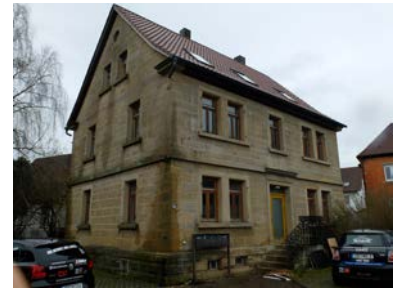
Ludwigstraße 39: Wohnhaus, 1885 erbaut, Beispiel eines anspruchsvollen gründerzeitlichen Sandsteinbaus.
