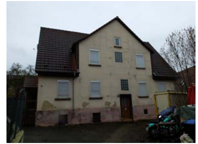
Schillerstraße 19: Ehemalige Scheune, im Kern 19. Jh. (verputzter Fachwerkbau), 1905 als Wohnhaus eingerichtet, dabei wohl Zwerchhausanbau; Beispiel der Umnutzung der vorstädtischen, landwirtschaftlich geprägten Bebauung zu Wohnzwecken.
