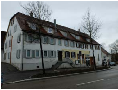
Schillerstraße 17 und 17/1: Langgestrecktes Wohnhaus mit ehem. Ökonomieteil (ehem. Ziegelhütte), im Kern wohl 18. Jh., 1884 erweitert, 1910/17 als Maschinenfabrik eingerichtet und erweitert, modern überformt; baulicher Hinweis auf die einstige Ziegelvorstadt und die frühindustrielle Entwicklung am Stadtrand.
