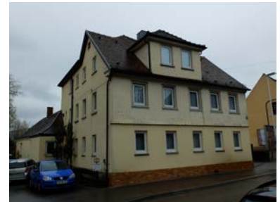
Schillerstraße 14: Wohnhaus eines Handwerkes (Schreiner), 1872 erbaut, später überformt, baulicher Hinweis auf die vorstädtische, handwerklich geprägte Bebauung in Crailsheim.
