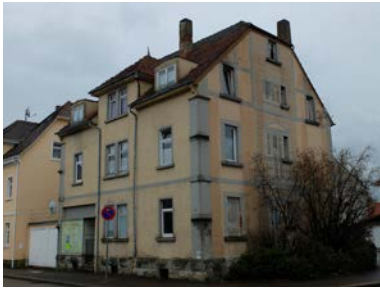
Schönebühlstraße 24: Wohnhaus, 1903 erbaut, modern überformt; Beispiel für das gründerzeitliche Bauen am Stadtrand in markanter Ecklage.
