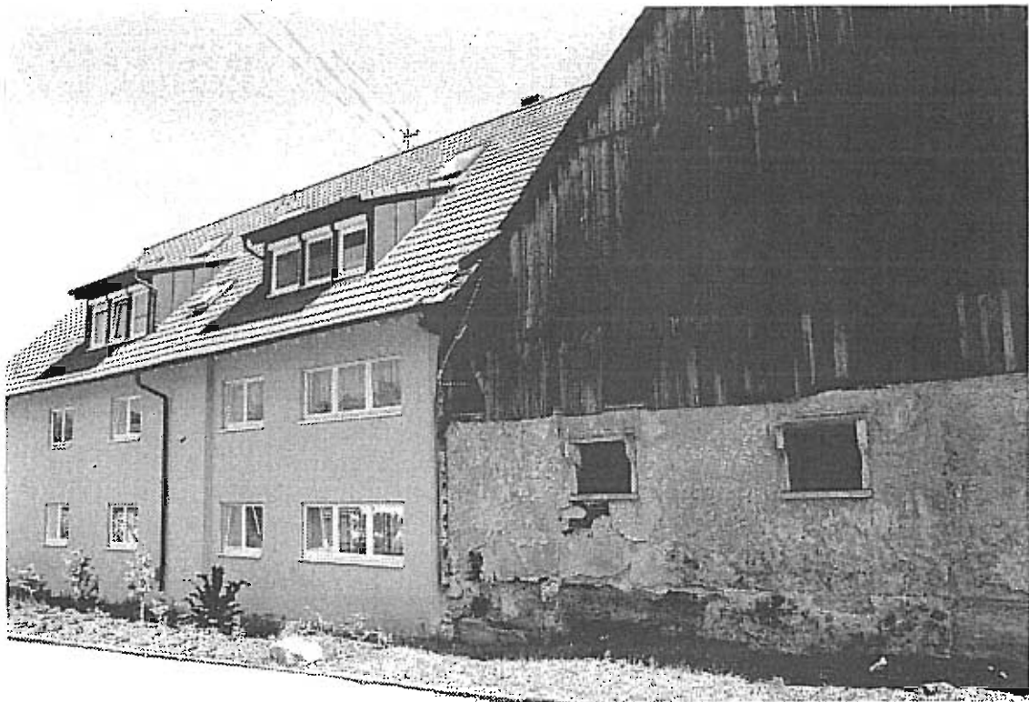
Neubau neben leerstehender Scheune in sehr schlechtem Gebäudezustand
