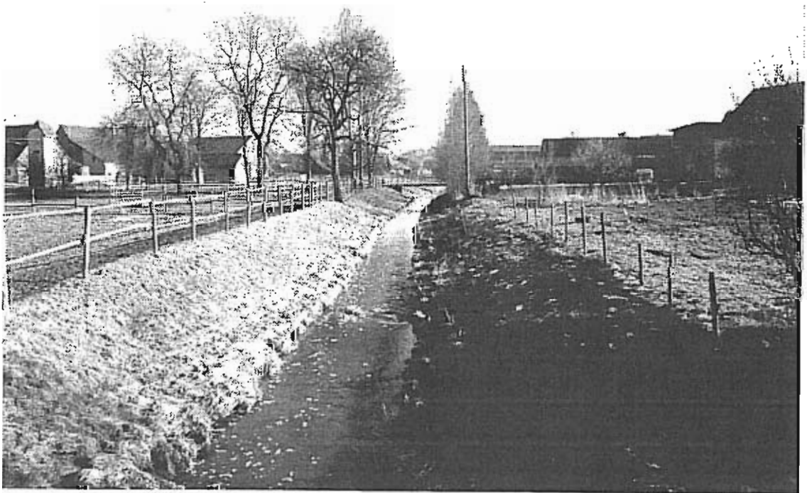
Fußgängerstege führen über die Maulach und verbinden den Großteil und den Kleinteil miteinander.
