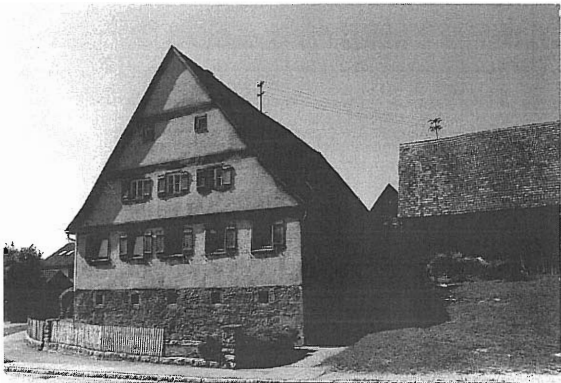
Kulturdenkmal Langäckerstraße 1, Einhaus um 1700
