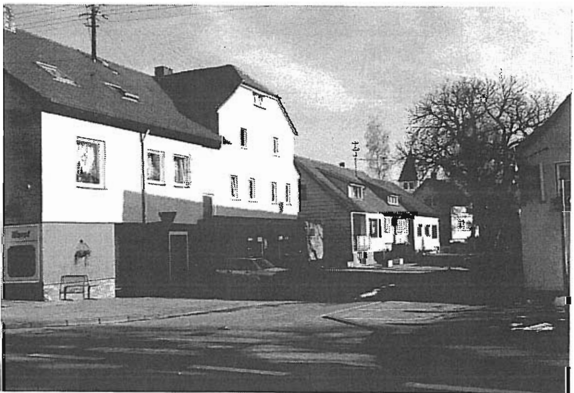
Ein- und zweigeschossige Gebäude bilden eine Gebäudereihe.
