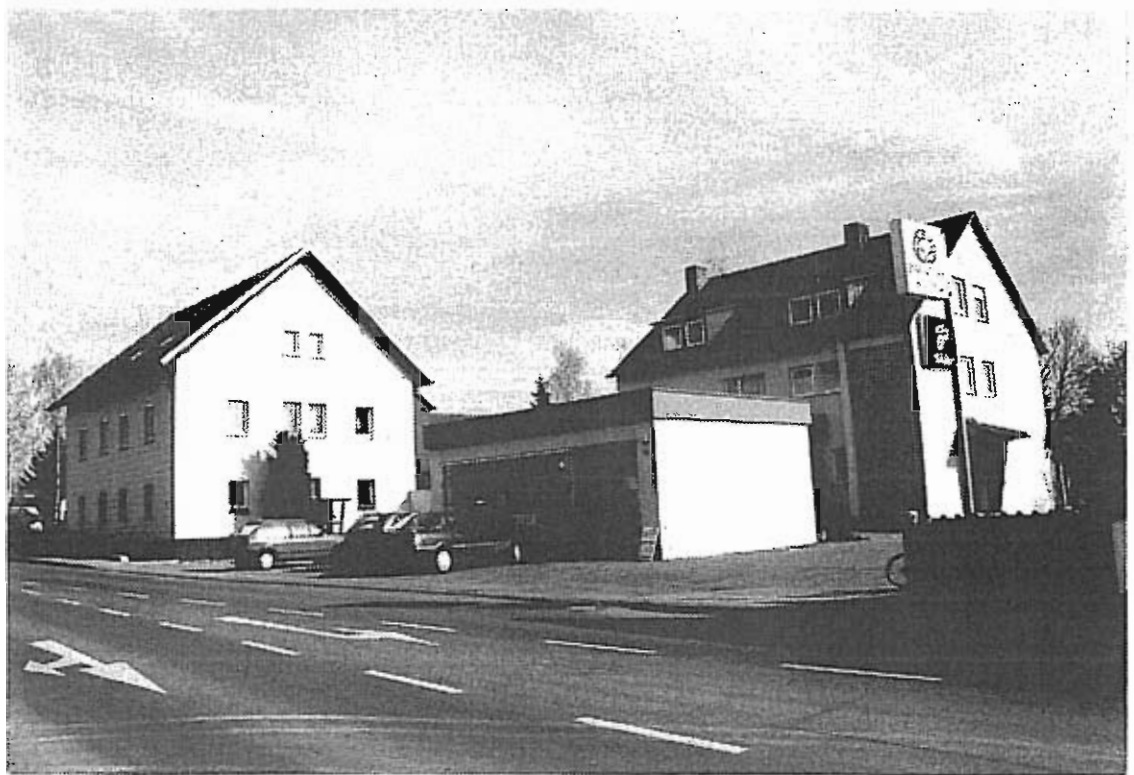
Ortsbildbeeinträchtiges Gebäude, Gestaltungsmängel an Gebäuden und im Freiraum
