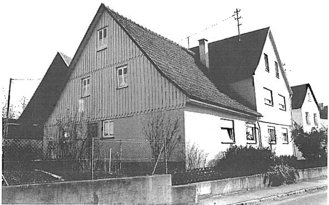
Ortsbildprägendes Gebäude - Gestaltungsmängel an der Straßenfassade
