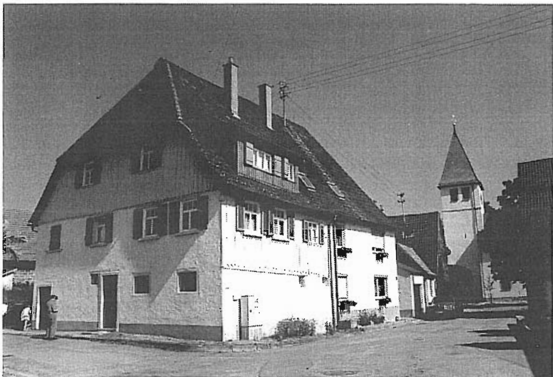
Kulturdenkmal Herrengasse 3, Doppelhaushälfte, Wohnstallhaus, frühes 18. Jahrhundert
