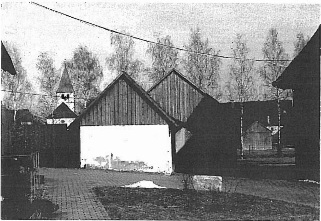
Holzverschaltete Nebengebäude im Kleinteil - im Hintergrund Kirche und landwirtschaftliche Gebäude im Großteil
