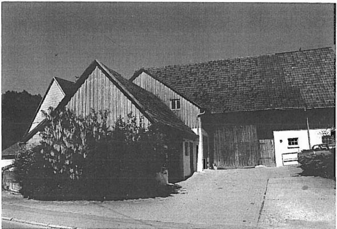
Die (einstige) landwirtschaftliche Nutzung ist an dem Scheunentor ablesbar. Die ziegelgedeckten Satteldächer haben knappe Dachüberstände.
