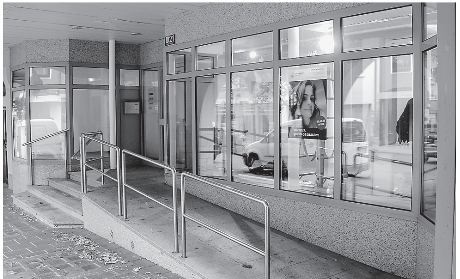
Der Eingang zur neuen Galerie ist noch unscheinbar, drinnen sind derzeit noch Handwerker zugange. Foto: Stadtverwaltung
