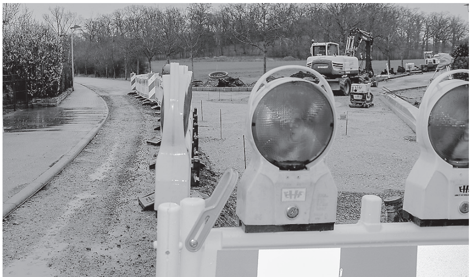
Der erste Bauabschnitt steckt bereits in der Endphase.
