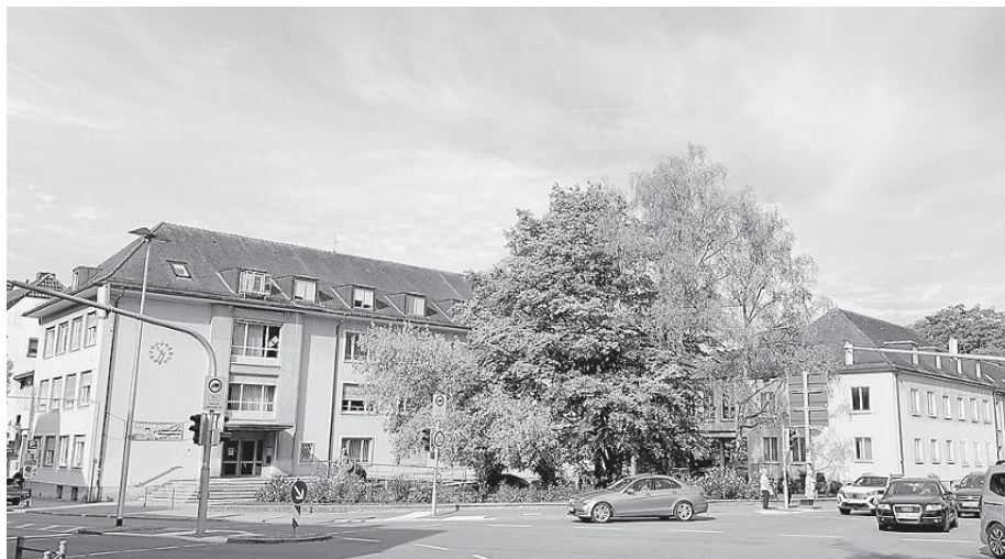
Das bestehende Gebäude des Finanzamts in der Schillerstraße soll durch einen Neubau an einem anderen Standort ersetzt werden.
