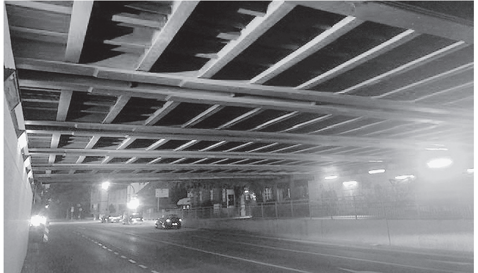
Für die Beleuchtung wurden vor Ort Tests gemacht. Foto: Stadtverwaltung
