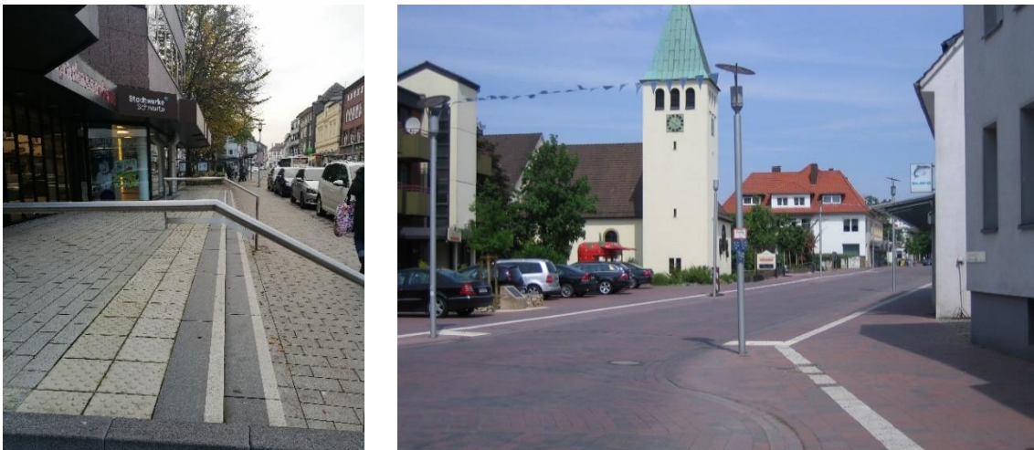
Abbildung 24: Taktile und visuell markierte Treppe (links), Taktiles Leitsystem (rechts)
