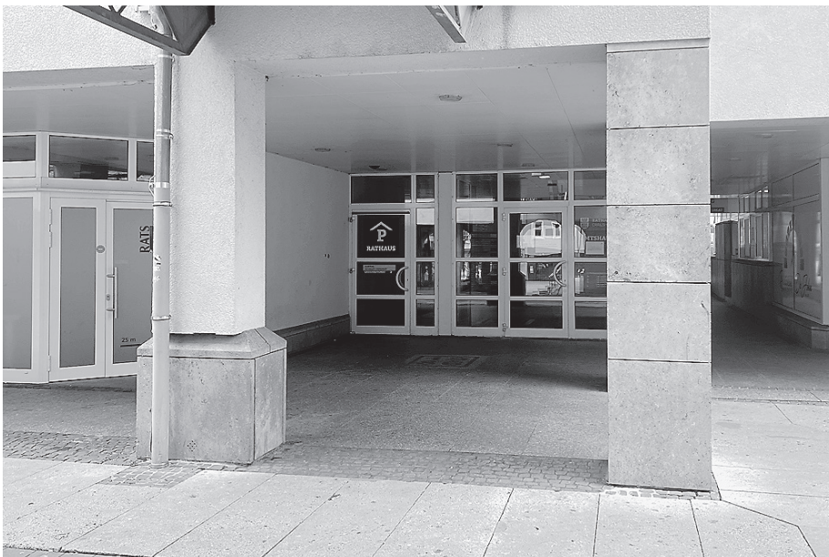
Der Aufzug im Amtshaus ist wegen Modernisierungsarbeiten ab dem 7. April für ein paar Wochen nicht mehr nutzbar. Foto: Stadtverwaltung
