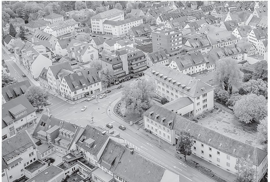
An der Kreuzung am Finanzamt wird umfassend saniert.
